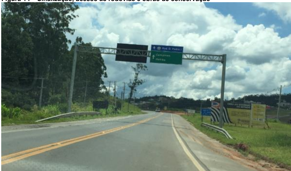
Figura 14 – Sinalização, acesso às rodovias e obras de conservação
