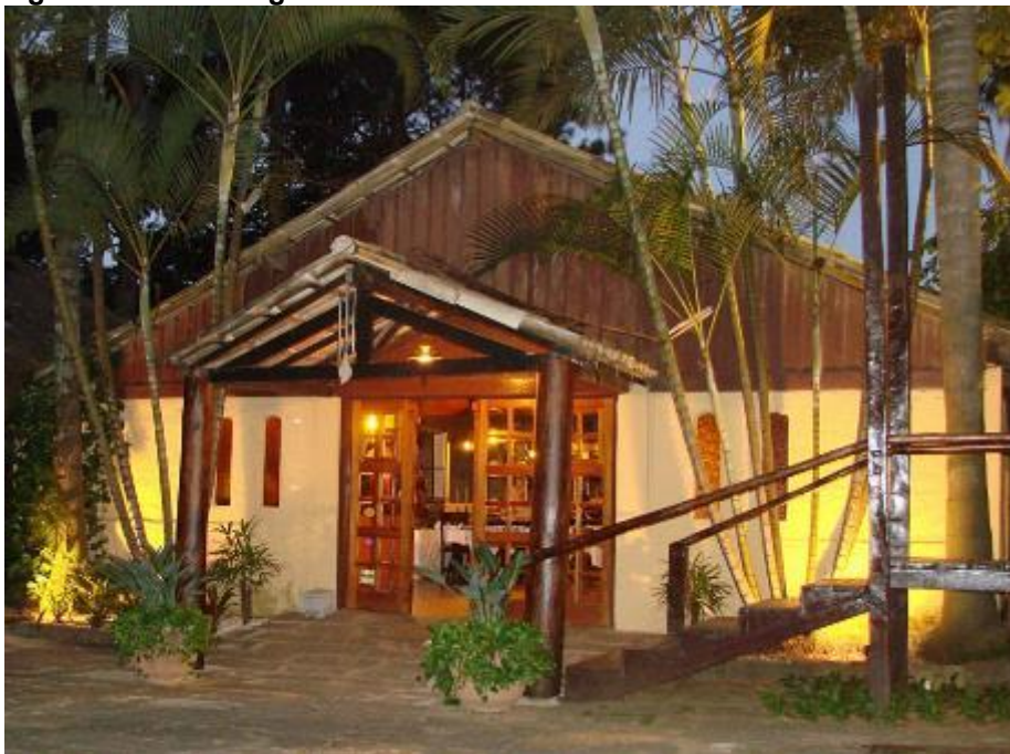
Figura 163 – Estalagem Dom João
